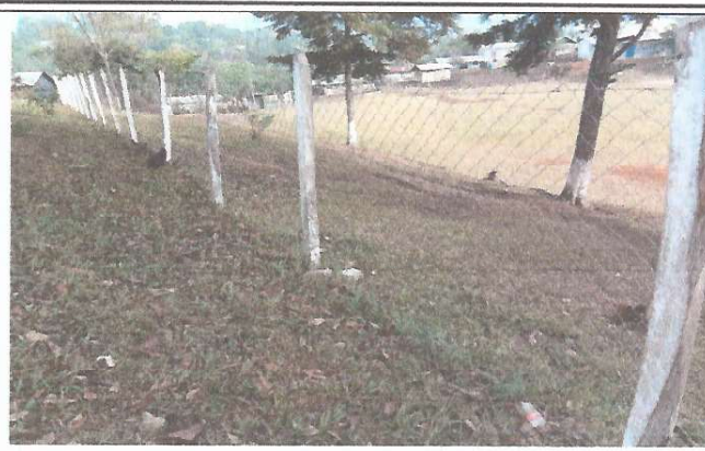
Foto 2: segunda parte del muro de maya
